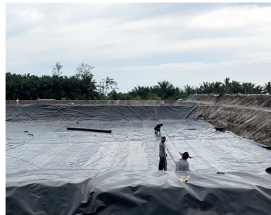
Pemasangan pelapis HDPE pada kolam budidaya
