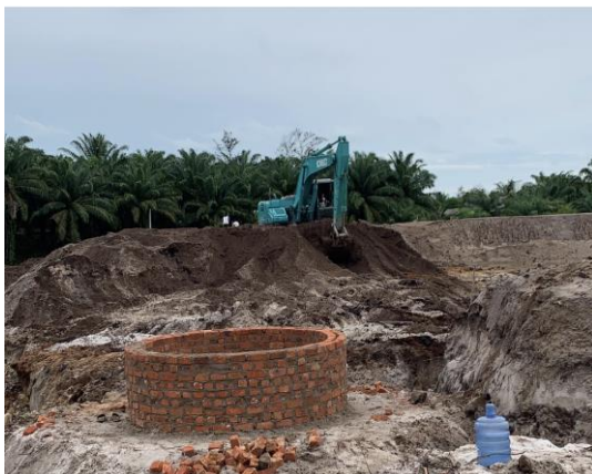
Konstruksi Saluran Pembuangan
