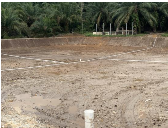
Pemasangan instalasi pipa dalam tambak
