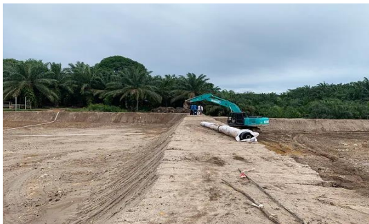
Pembentukan Cut & Fill tanggul Kolang Budidaya
